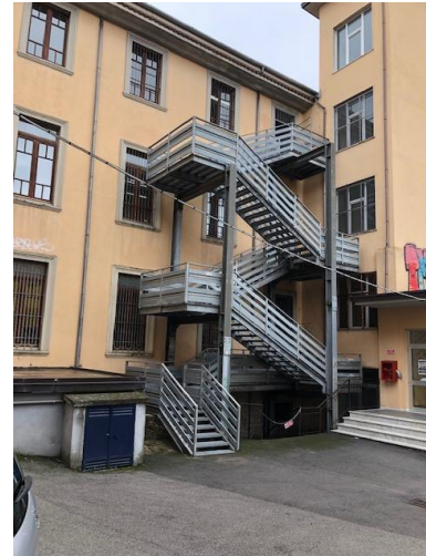
Scala di emergenza lato ovest
