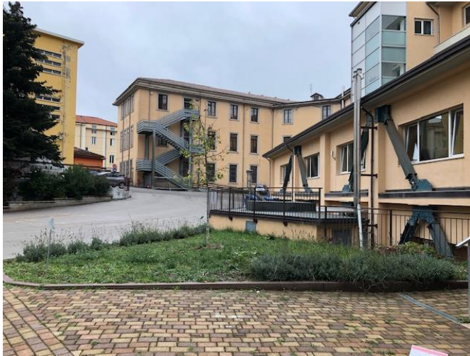
Scala di emergenza lato est
